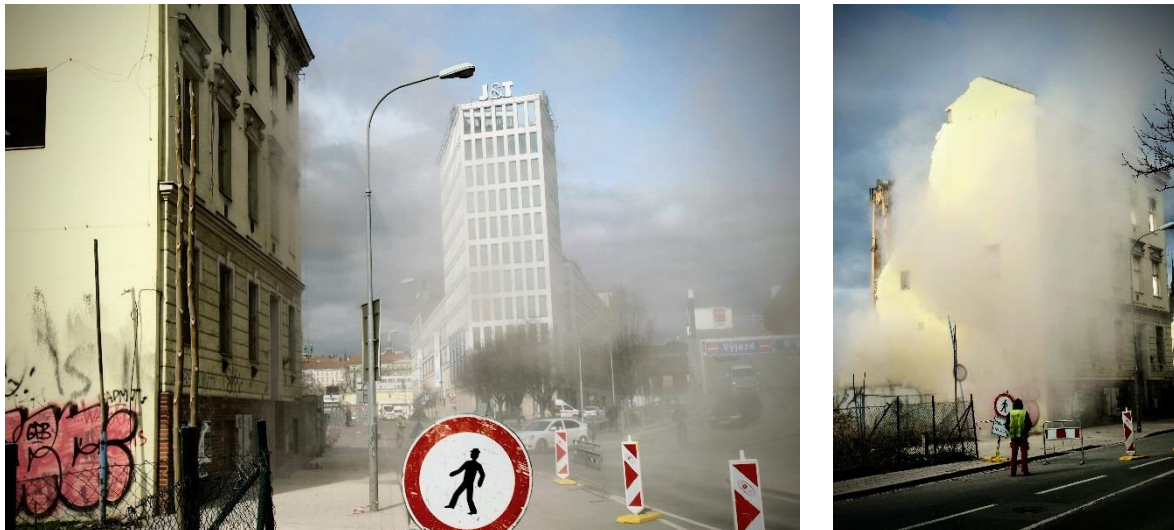
Obrázek 7 – demolice budovy v ulici Trnitá v souvislosti s přípravou na stavbu Paláce Trnitá. 3. března 2019, 11:10. 105 m vzdušnou čarou od stanice imisního monitoringu Brno-Zvonařka, která je v zástínu budovy Městského úřadu Šlapanice. Foto: Jáchym Brzezina, ČHMÚ Brno.
